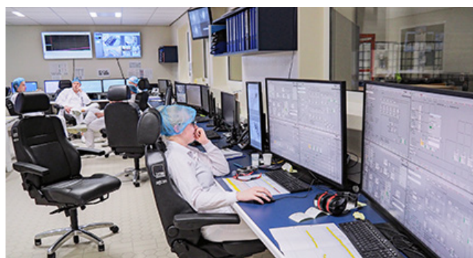
Salle de commande
