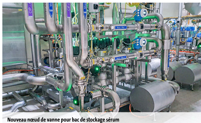
Nouveau nœud de vanne pour bac de stockage sérum
